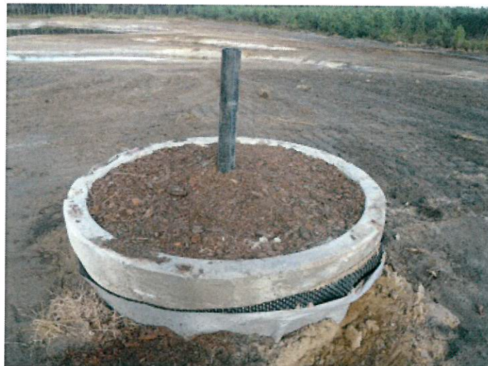
Figure 2-3 : Schéma du puits de dégazage
